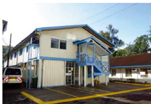
熱帯医学研究所ケニア拠点 （コンテナハウス）
