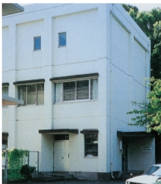
熱帯性病原体感染動物実験施設
