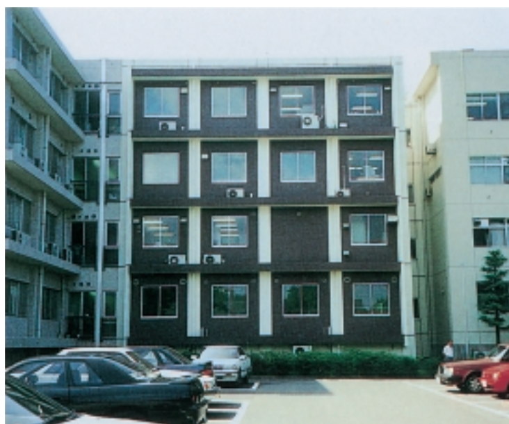
熱帯病資料情報センター(3・4階)を含む熱研本館の第3・4次増築部分
